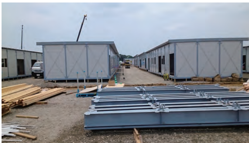
熊本仮設住宅建設風景
