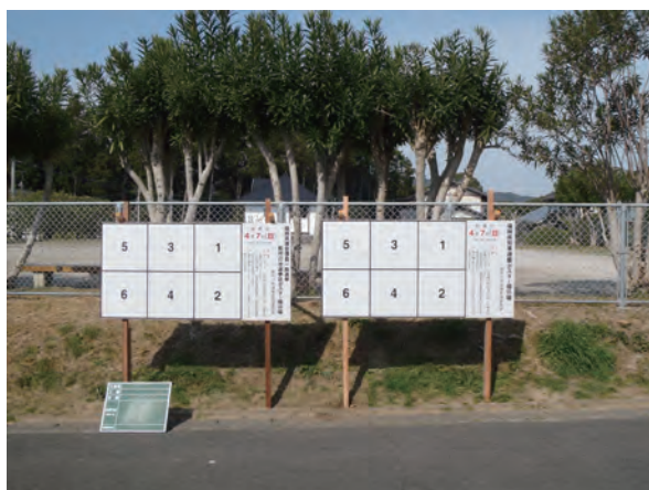
選挙看板設置工事
